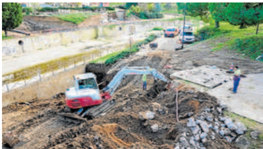
La obra del Rivillas, parada, volverá a tener operarios en unos días. HOY
