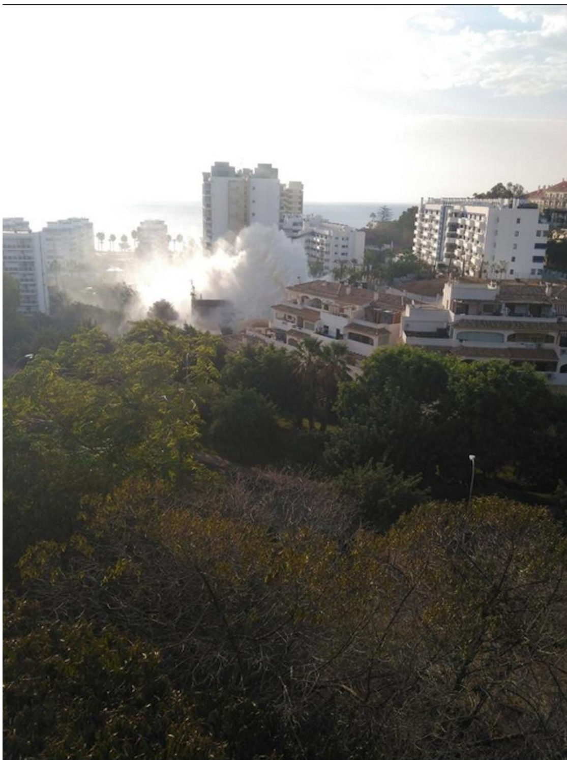
El tramo que se va a sustituir discurre junto al hotel Los Patos donde ya ha reventado varias veces.
